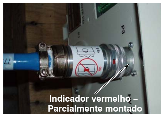
Figura 3-9 Conector de cabo unifilar parcialmente montado
