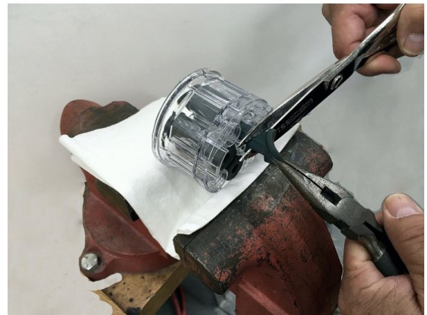
Рис. 29 Демонтаж пережимного клапана
