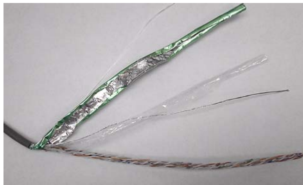
Figure 3-9 Terminaison de câble Ethernet, étapes 3-4
