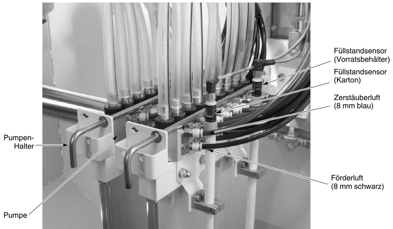
Abb. 3-4 Pumpe, Luftschlauch und Pulverschlauch installieren
