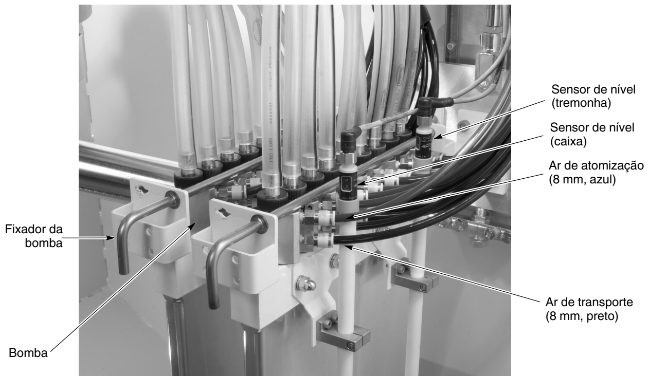
Figura 3-4 Instalação de bombas, tubos de ar e mangueiras de alimentação de pó
