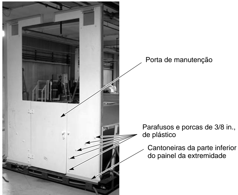
Figura 4 Instalação dos painéis das extremidades
