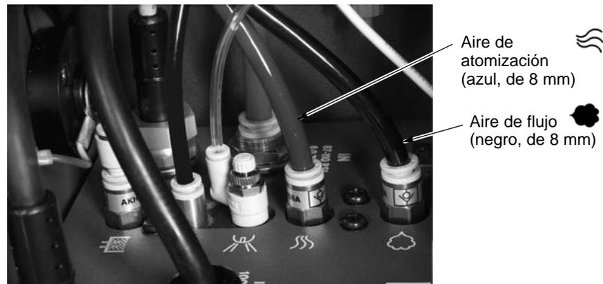
Fig. 2-9 Conexiones de los tubos de aire de atomización y de flujo a la unidad de potencia
