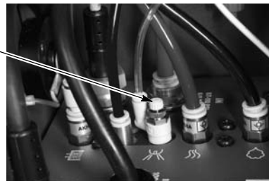
Bild 3-3 Placering av ventil för spolluft för elektrod
